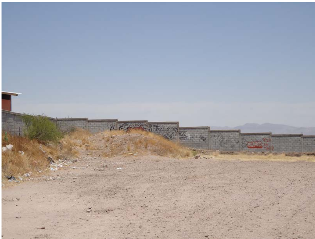
Vista exterior del Muro parte sur de la Facultad
