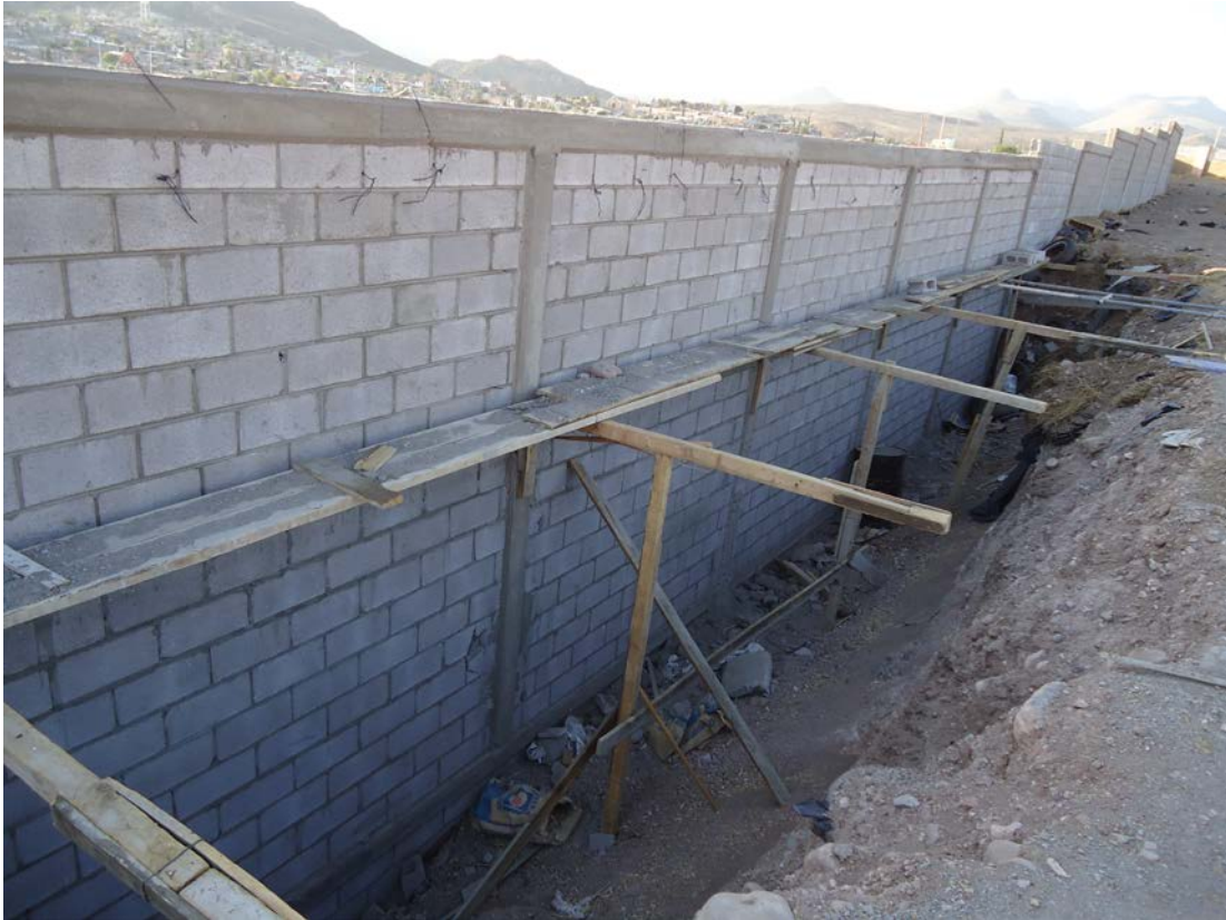
Vista de muro de block ya reparado.
