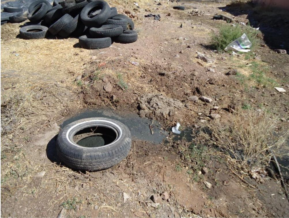
Fuga de aguas residuales por registro por obstrucción en el drenaje
