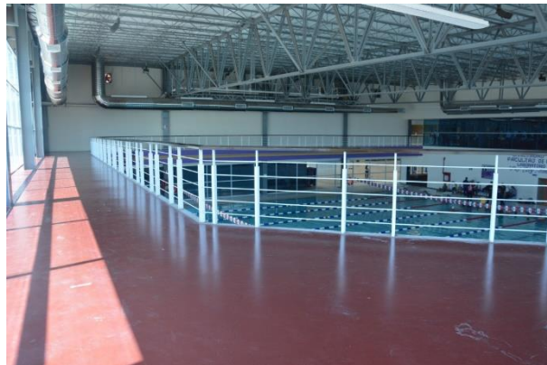
Corredor (cruce por arriba de la alberca)
