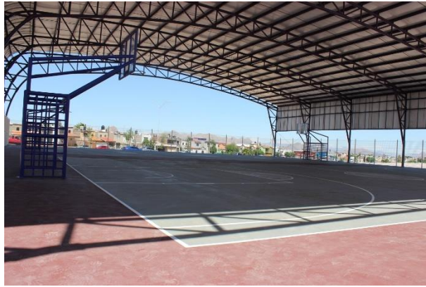
Vista desde el interior
