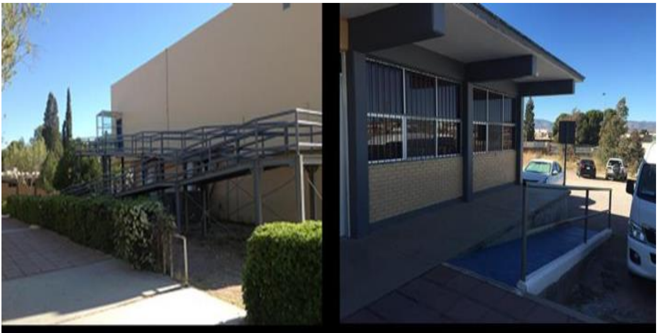
Imágenes de algunas rampas y accesos ubicados en la Facultad.
