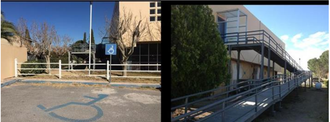
Imagen de área de estacionamiento y rampa para biblioteca.
