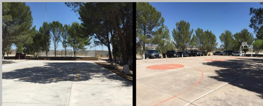
Figura 72. Rehabilitación de las canchas deportivas de la Facultad
