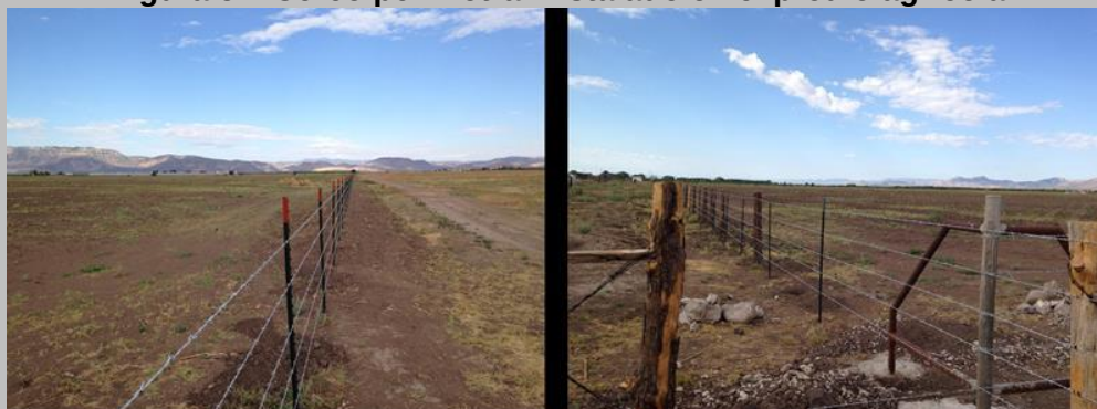
Figura 51. Cerco perimetral instalado en el predio agrícola
