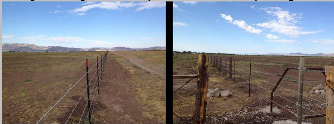
Figura 53. Imágenes del cerco perimetral instalado en el predio agrícola
