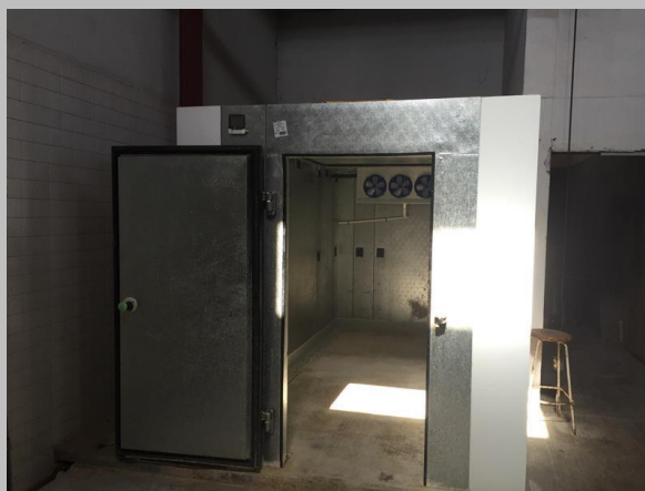
Figura 39. Imagen del nuevo cuarto frío del taller de carne
