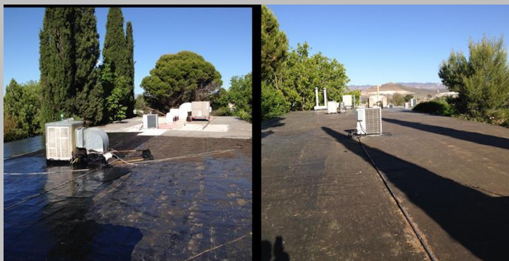
Figura 72. Impermeabilización del edificio de planeación y de extensión
