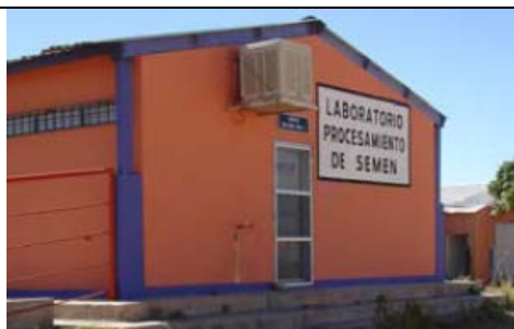
Vista exterior Laboratorio de Procesamiento de Semen
