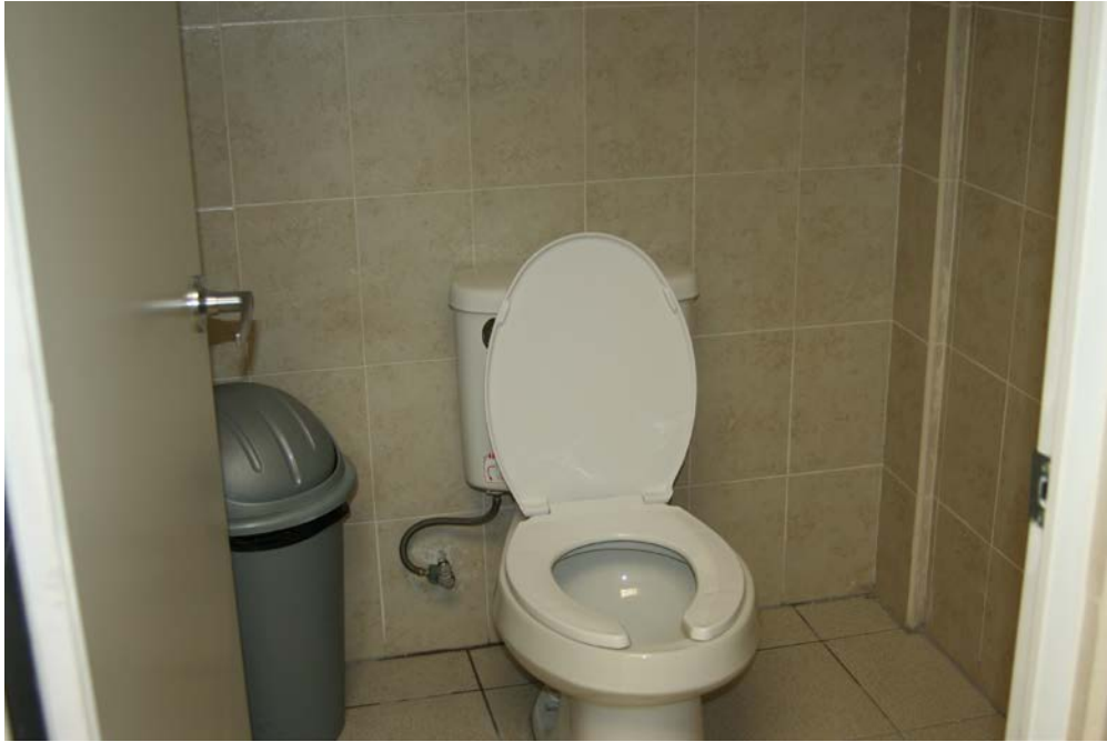
Remodelación de sanitarios en Posgrado
